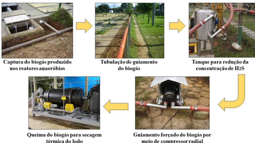
**Figura 1** | Extração ativa do biogás durante o processo de aproveitamento energético para a secagem térmica do lodo de esgoto.
